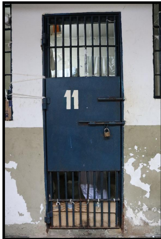
Figura 25 - Cella da ala de PCD com papelão tampando a grade embaixo
