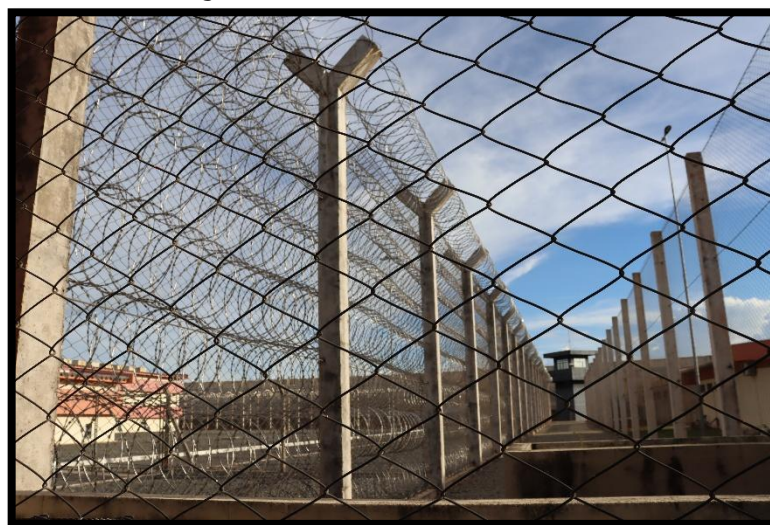
Figura 71 - Estrutura externa da PFBRA
