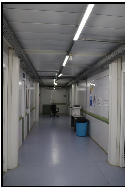
Figura 45 - Estrutura interna da UBS
