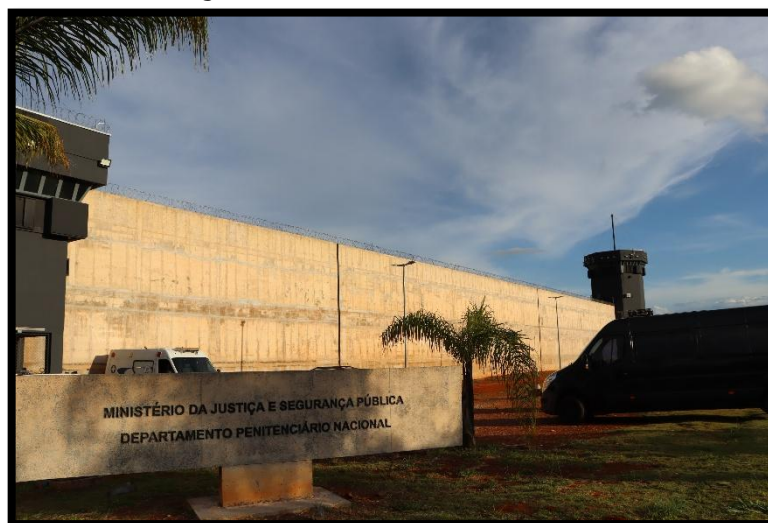
Figura 72 - Estrutura externa da PFBRA
