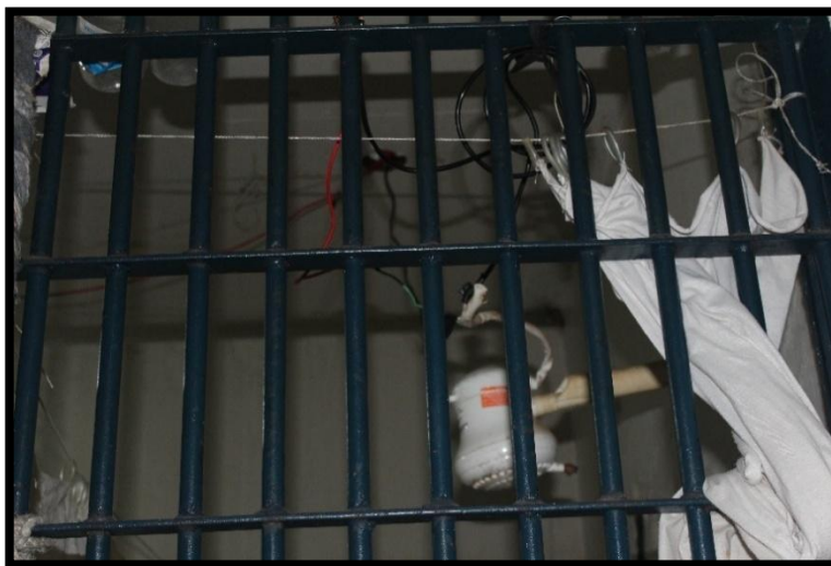
Figura 27 - Chuveiro da cela da ala PCD
