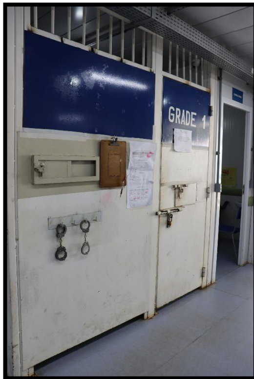
Figura 50 - Sala de espera para as pessoas presas
