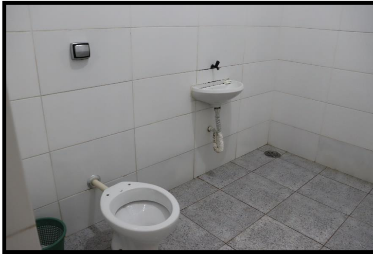
Banheiro do quarto da enfermaria. Fonte: Acervo MNPCT, 2024.
