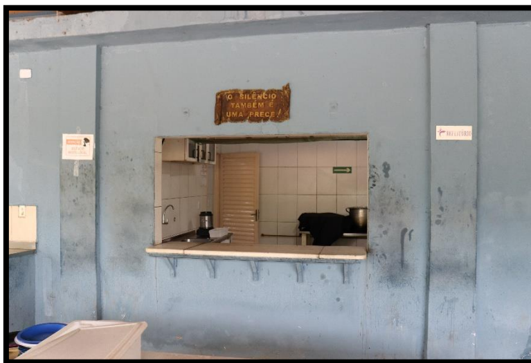
Acesso à cozinha pelo refeitório.
