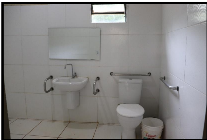
Banheiro individual equipado com barras laterais. Fonte: Acervo MNPCT, 2024.
